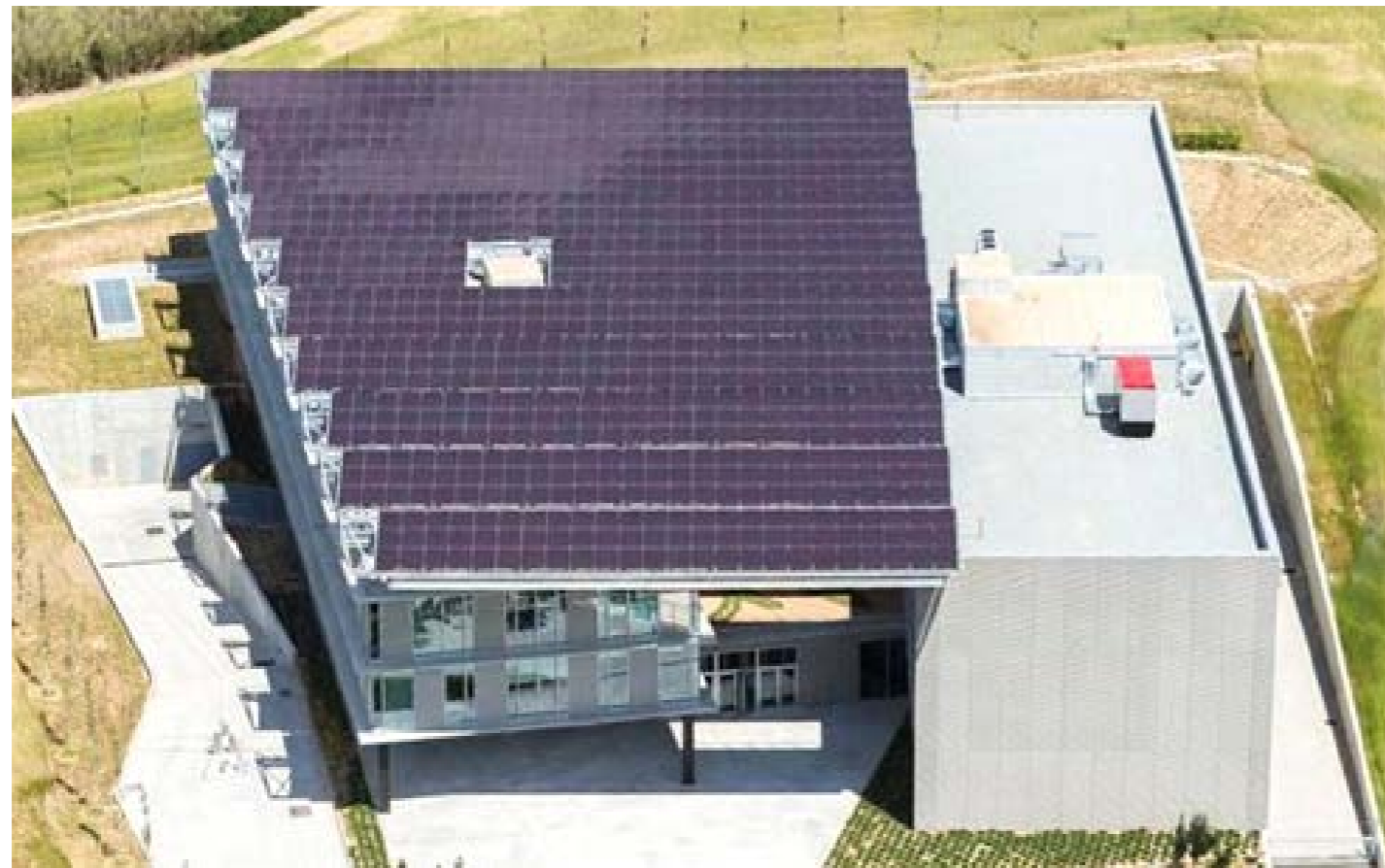
Pérgola fotovoltaica del edificio de SENER en Barcelona (España).
